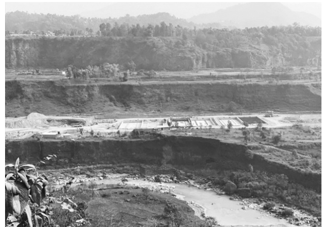
浄水場建設現場
