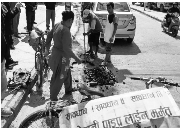
漏水箇所を人力で掘削
