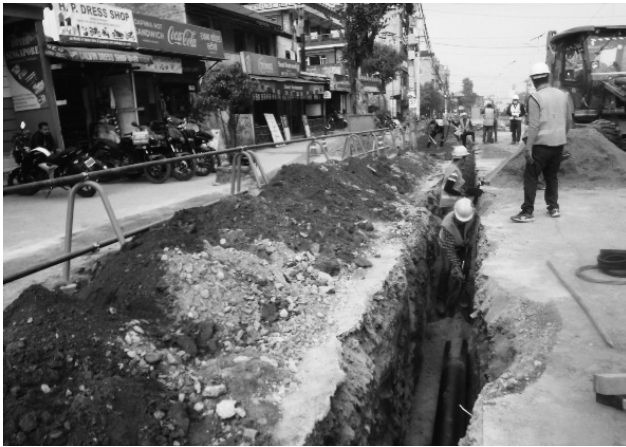
配水管布設工事現場
