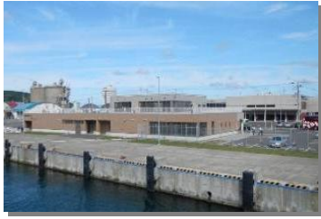
稚内国際フェリーターミナル
