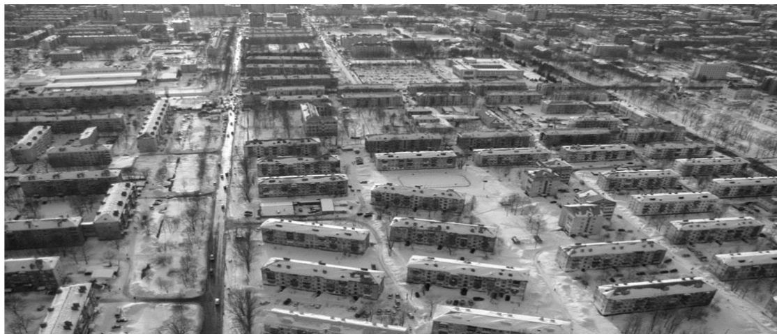
取壊しが計画されている団地群（耐震構造欠陥）
