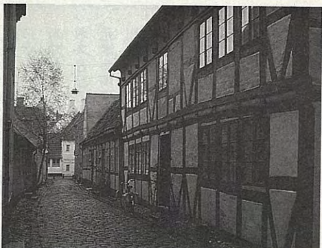
市街地の古い家並み。家の中は現代風に修理してある
