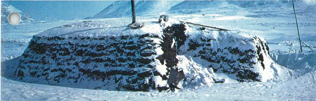
▲地下に埋め込んだエスキモーの家(アメリカ)
