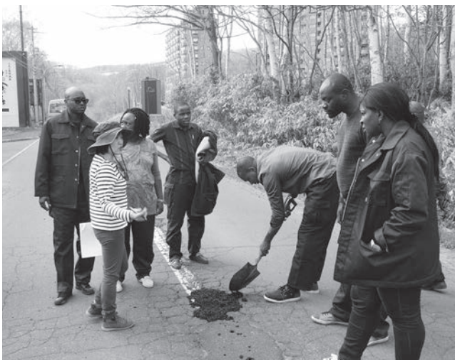
ニセコ町道にてポットホール補修の実習を行う研修員 （道路維持管理（E））
