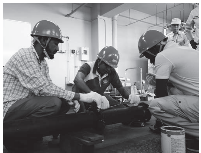
水道配管の接合の実習を学ぶ研修員 （上水道施設技術総合（B））
